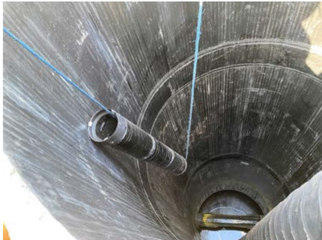
Einbringen der Kurzrohre in das Altrohr
