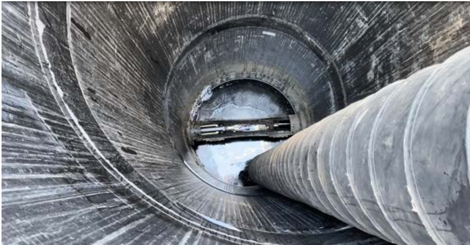
Einschieben des Kurzrohres mittels Kanalroboter
