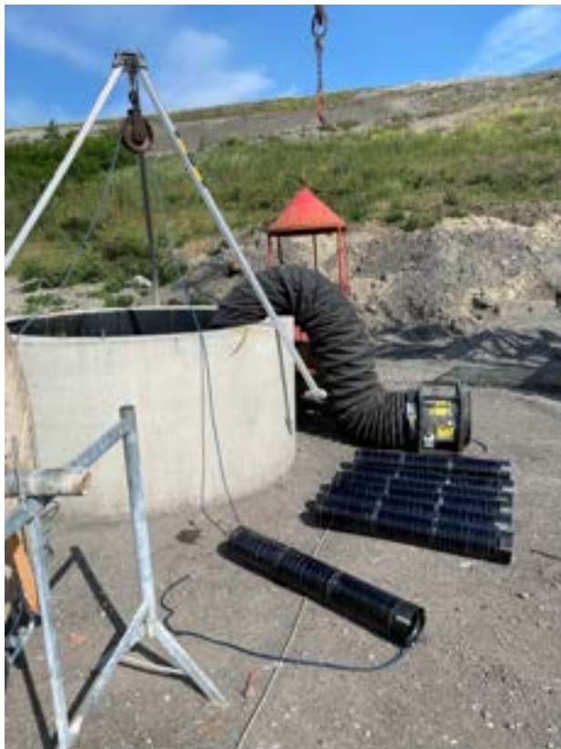
Einbringen der Kurzrohre in das Altrohr
