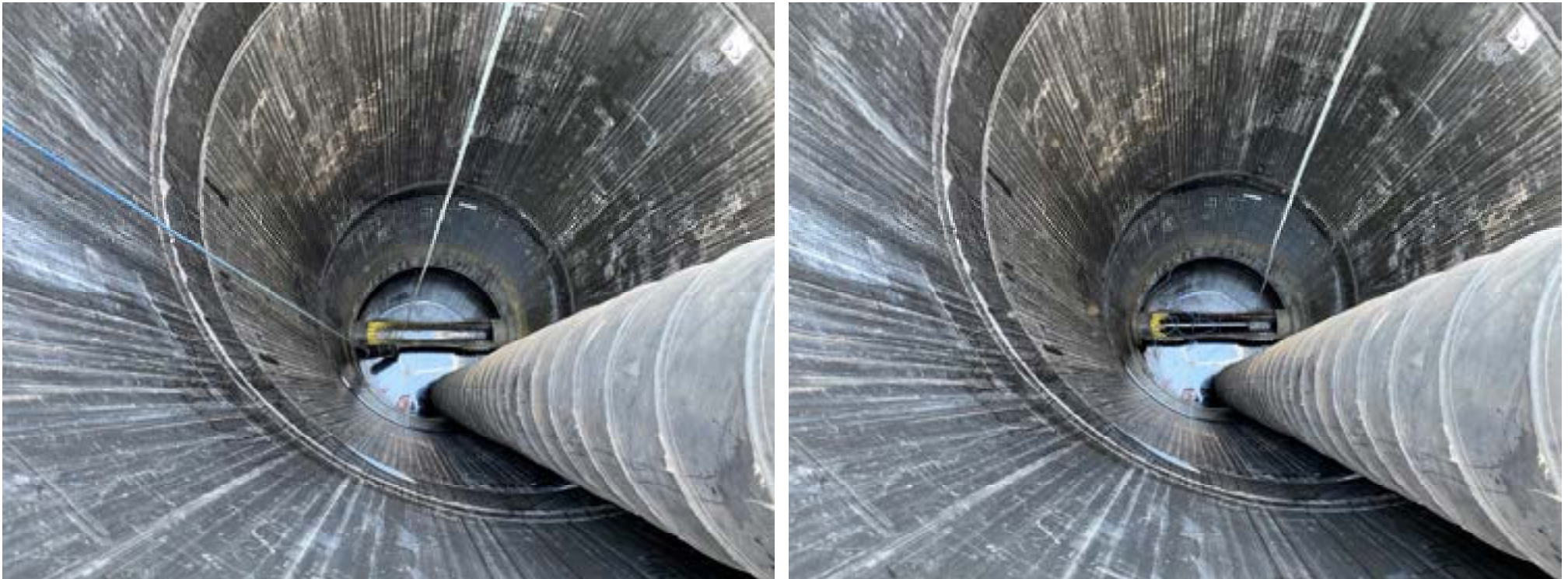
Einbringen der Kurzrohre in das Altrohr
